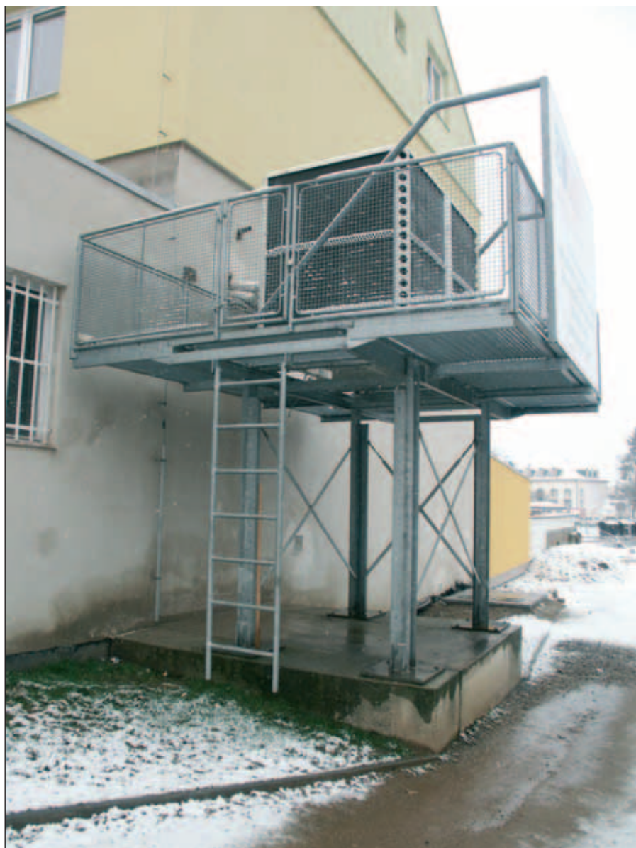
Obrázek č. 8: Tepelné čerpadlo v Písku neobstálo, nahradilo ho dálkové tepla z místní teplárny.
