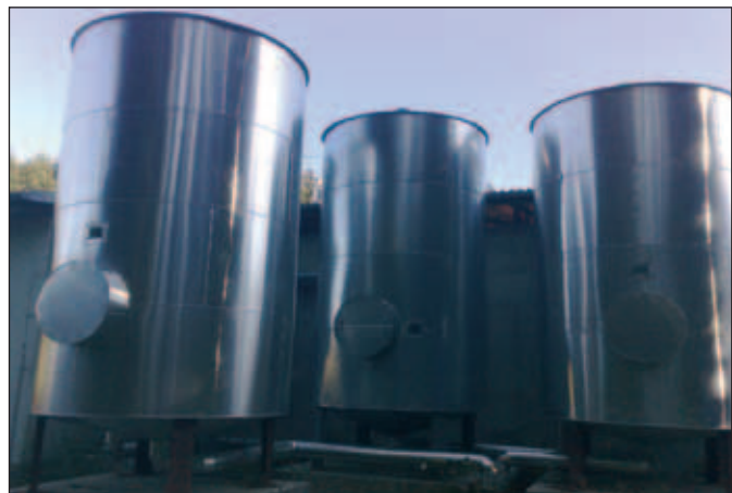
Obrázek č. 4: Tři ze čtyř desetikubikových akumulátorů tepla v ZOO Olomouc
