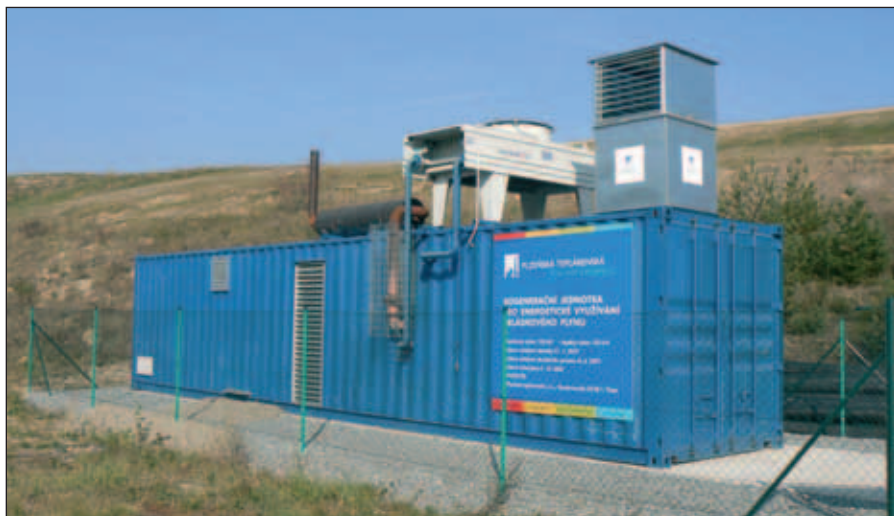
Obrázek č. 10: Kogenerační jednotka Plzeňské teplárenské na skládce v Chotíkově využívá skládkový plyn s obsahem metanu k výrobě elektřiny.
